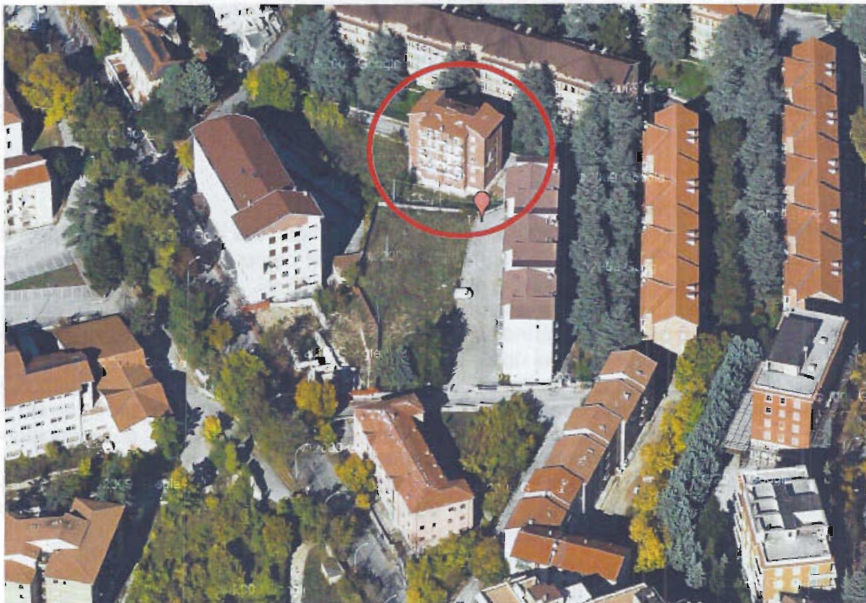
01 – vista aerea del comparto ed individuazione dell'edificio in questione
