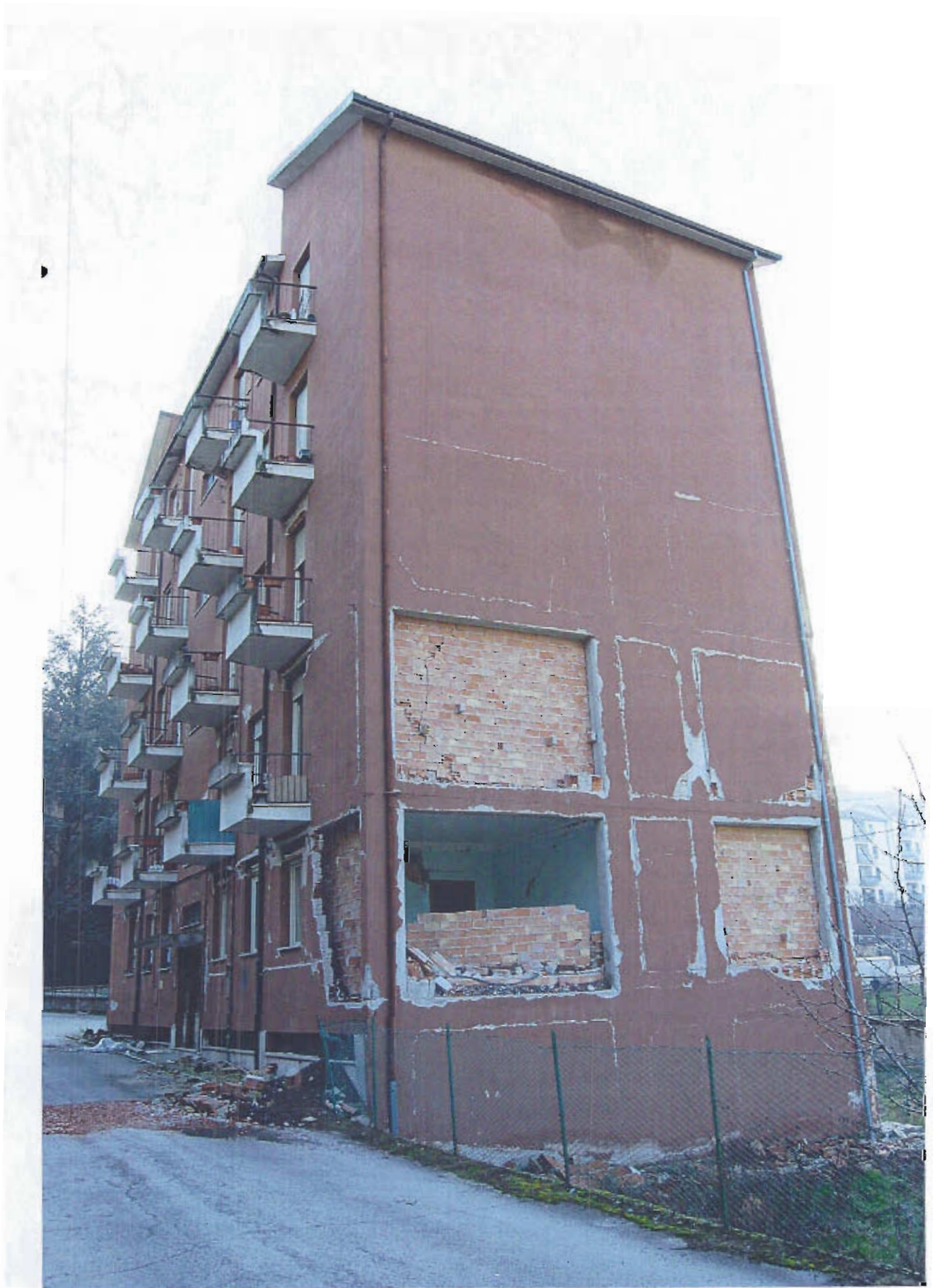
03 – il fronte nord visto dal cancello di ingresso
