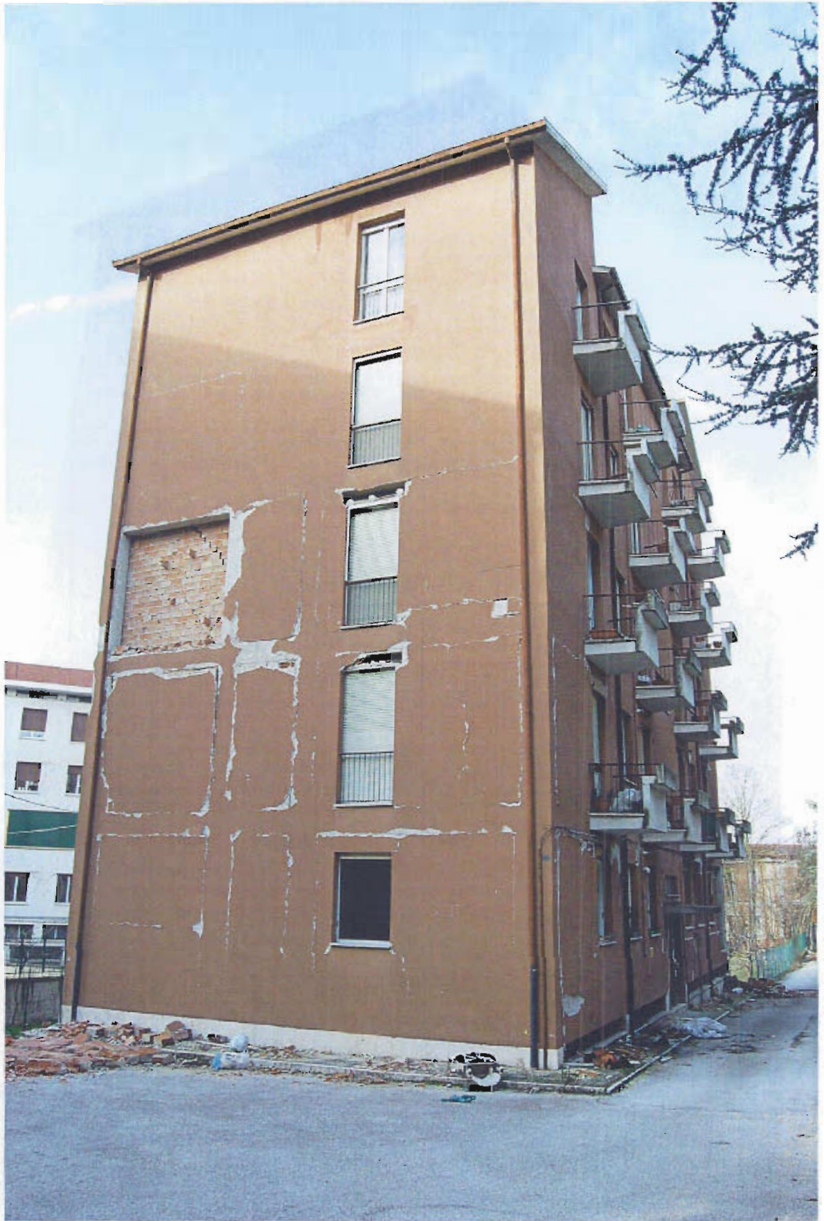
04 – il fronte sud dal fondo del lotto
