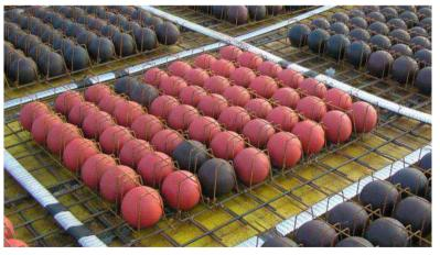
Per le chiusure orizzontali verrà utilizzata una tipologia di solaio costituito da una piastra in calcestruzzo, alleggerita grazie all'utilizzo di elementi cavi in polietilene ad alta densità HDPE riciclato al 95% e riciclabile, inseriti in una speciale gabbia di rete elettrosaldata, opportunamente sagomata, che funge anche da distanziale tra l'armatura inferiore e superiore.
