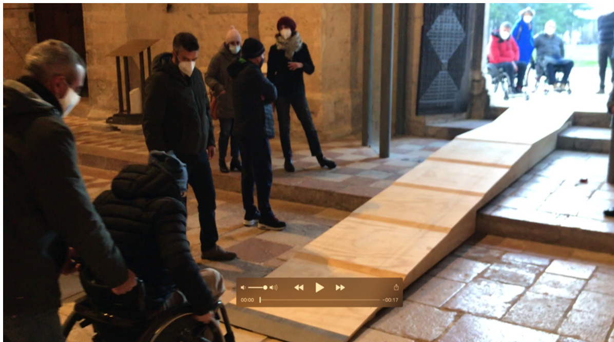
Fasi dell'attività di consulenza per il superamento delle barriere architettoniche nella basilica di Collemaggio. Sperimentazione gradino agevolato
