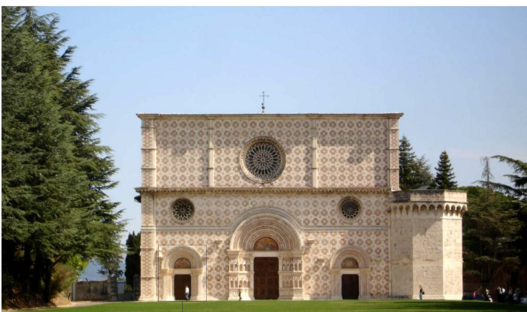
INTERVENTO INGRESSO SULLA FACCIATA PRINCIPALE
