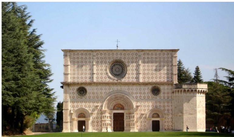
INTERVENTO INGRESSO SULLA FACCIATA PRINCIPALE
