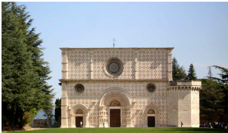
INTERVENTO INGRESSO SULLA FACCIATA PRINCIPALE
