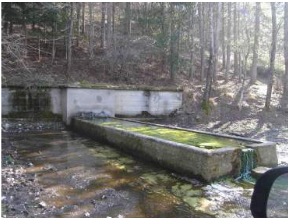
FIGURA 9 – FONTE SANTOGNA, CON LA CISTERNA DI CAPTAZIONE, I TRE FONTANILI E LA VASCA D'ABBEVERATA PER IL BESTIAME (FOTO SV BELOSI 2015).
