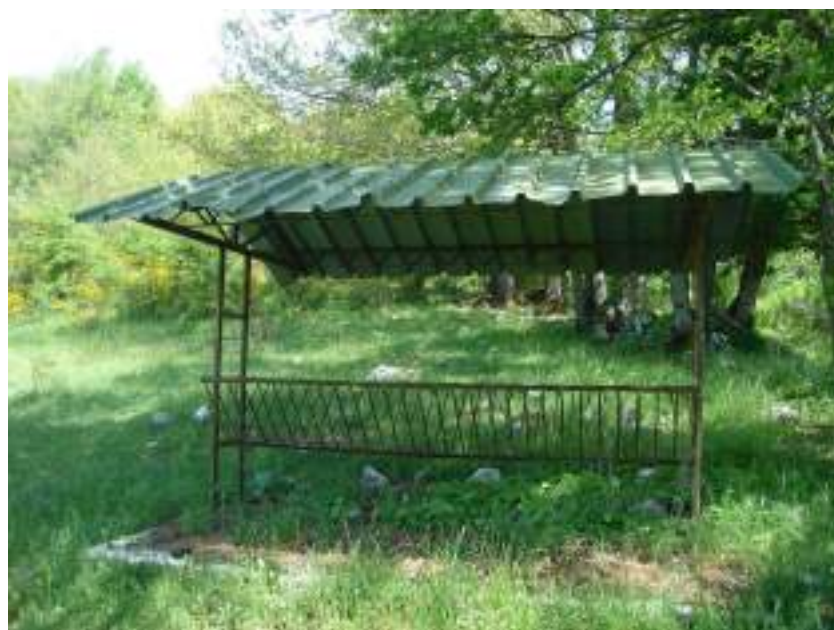
FIGURA 5 – UNA TETTOIA/MANGIATOIA PER CERVIDI ALL'INTERNO DEL RECINTO "DAINI", STRUTTURA METALLICA SU PLATEA IN CLS, IN BUONO STATO DI CONSERVAZIONE NONOSTANTE GLI OLTRE 40 ANNI D'ETÀ, REALIZZATA DALLA GESTIONE ASFD (FOTO BELOSI – SV 2015)
