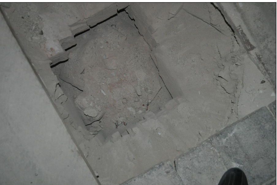
P1 Crollo pavimentazione della struttura voltata da smontare e rimontare
