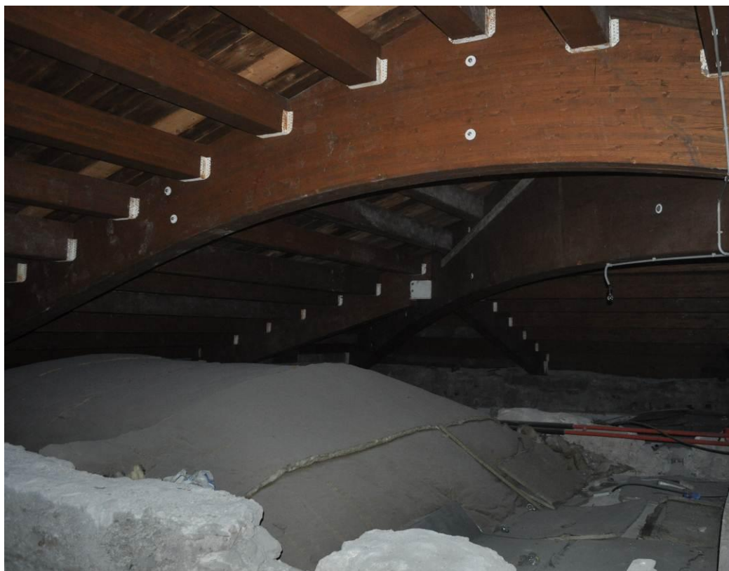
Sottotetto – trave in legno lamellare
