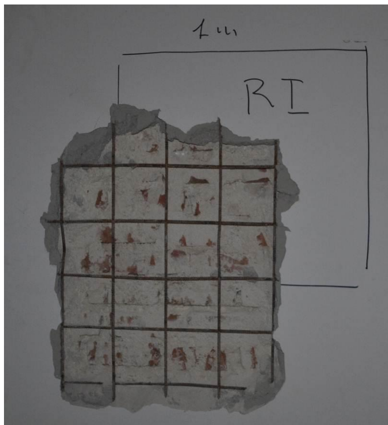
Secondo piano - consolidamento con rete metallica
