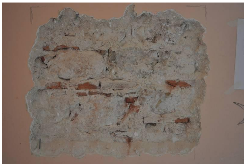
Figura 2: tipologia muraria in pietrame disordinato con inserti di laterizio
