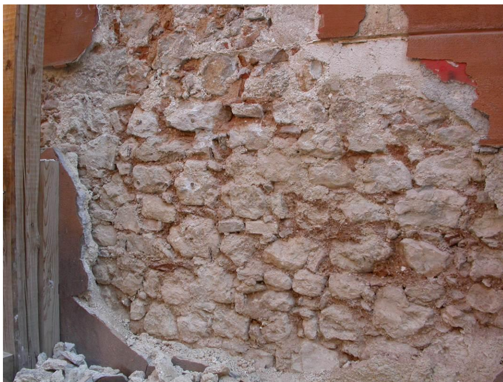
particolare dell'elemento murario provato.
