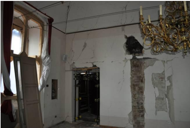
Figura 9: rottura degli architravi, discontinuità nelle pareti per inserti di canne fumarie, bucatore richiuse ...
