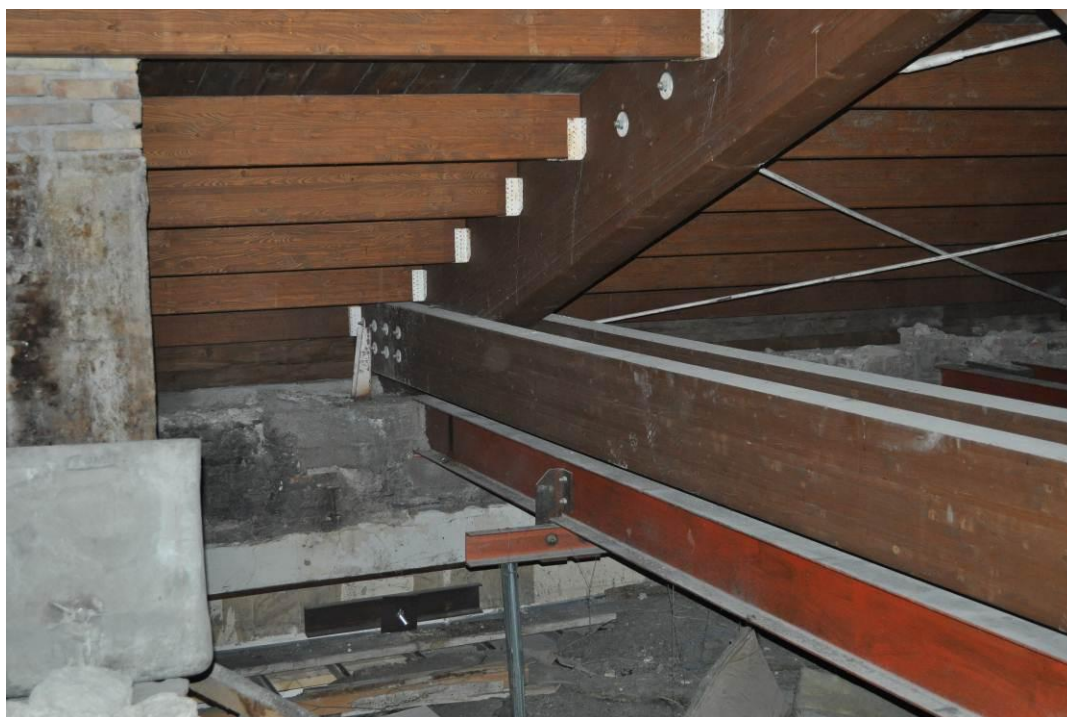
Sottotetto – cordolo in c.c.a. h= 1 m circa
