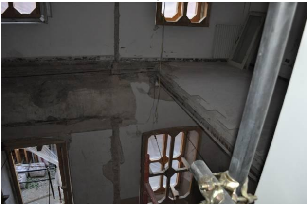
Figura 11: crollo di solai in ferro e laterizio
