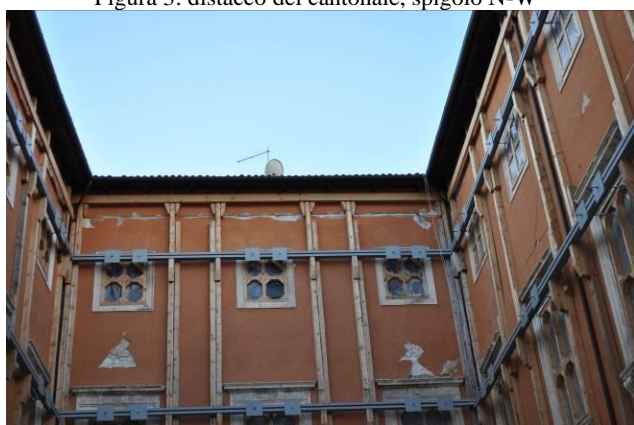
Figura 5: distacco parete – cordolo in c.a.
