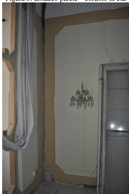
Figura 7: distacco pareti e rottura ammorsamenti
