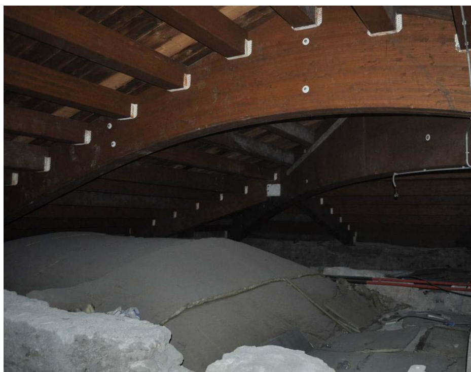
Sottotetto – trave in legno lamellare
