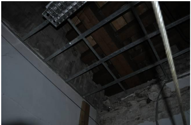
Figura 12: rottura dell'ancoraggio delle travi portanti di copertura di tipologia spingente
