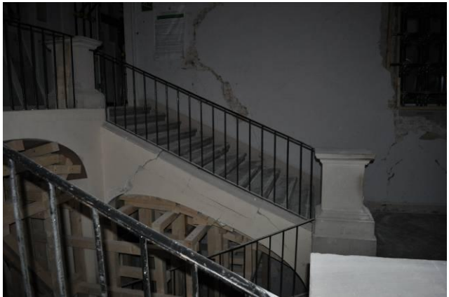
Figura 10: rottura della struttura portante dello scalone
