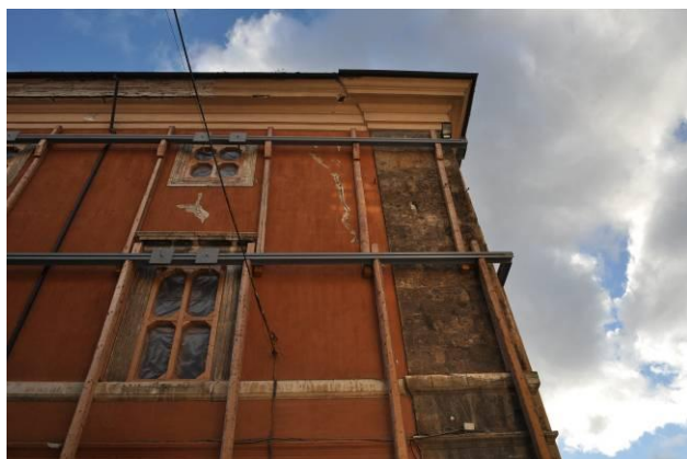
Figura 3: distacco del cantonale, spigolo N-W
