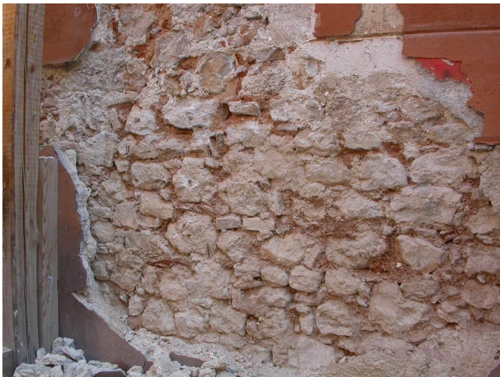
particolare dell'elemento murario provato.
