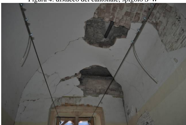
Figura 6: crollo parziale di strutture voltate
