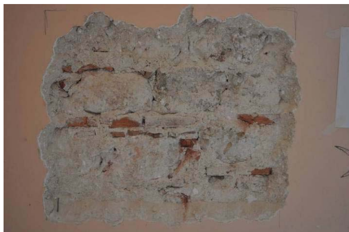
Tipologia muraria in pietrame disordinato con inserti di laterizio
