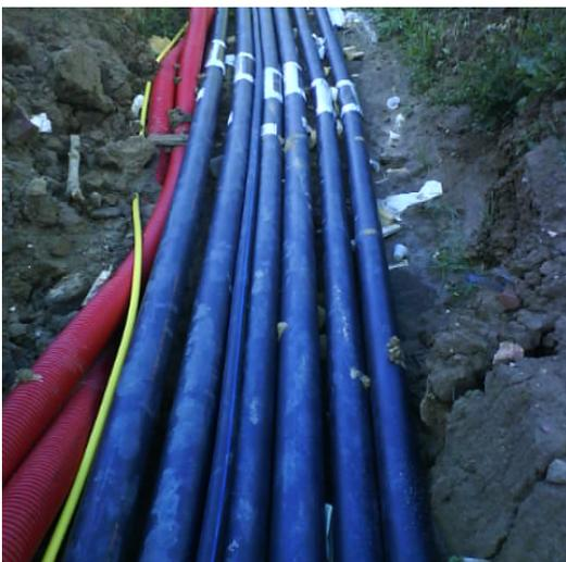
Figura 6 - Distribuzione dei fluidi termovettori (teleriscaldamento di Pistoia)
