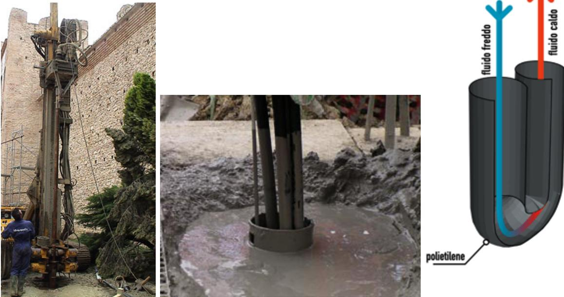
Figura 4 – Scavo e realizzazione di sonda geotermica e schema di funzionamento
