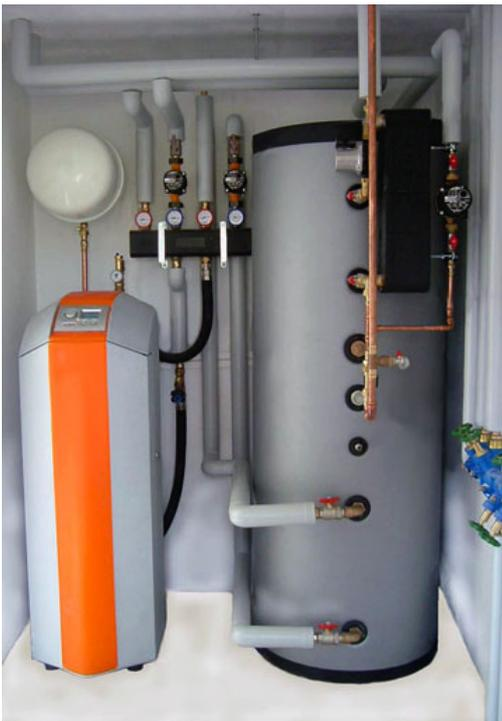
Figura 2 - Esempio di installazione domestica di pompa di calore geotermico con accumulo
