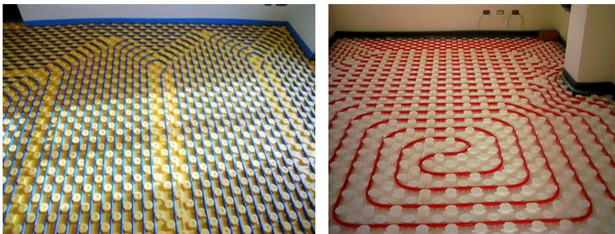
Figura 14 – Esempio di realizzazione di pannello radiante a pavimento.
