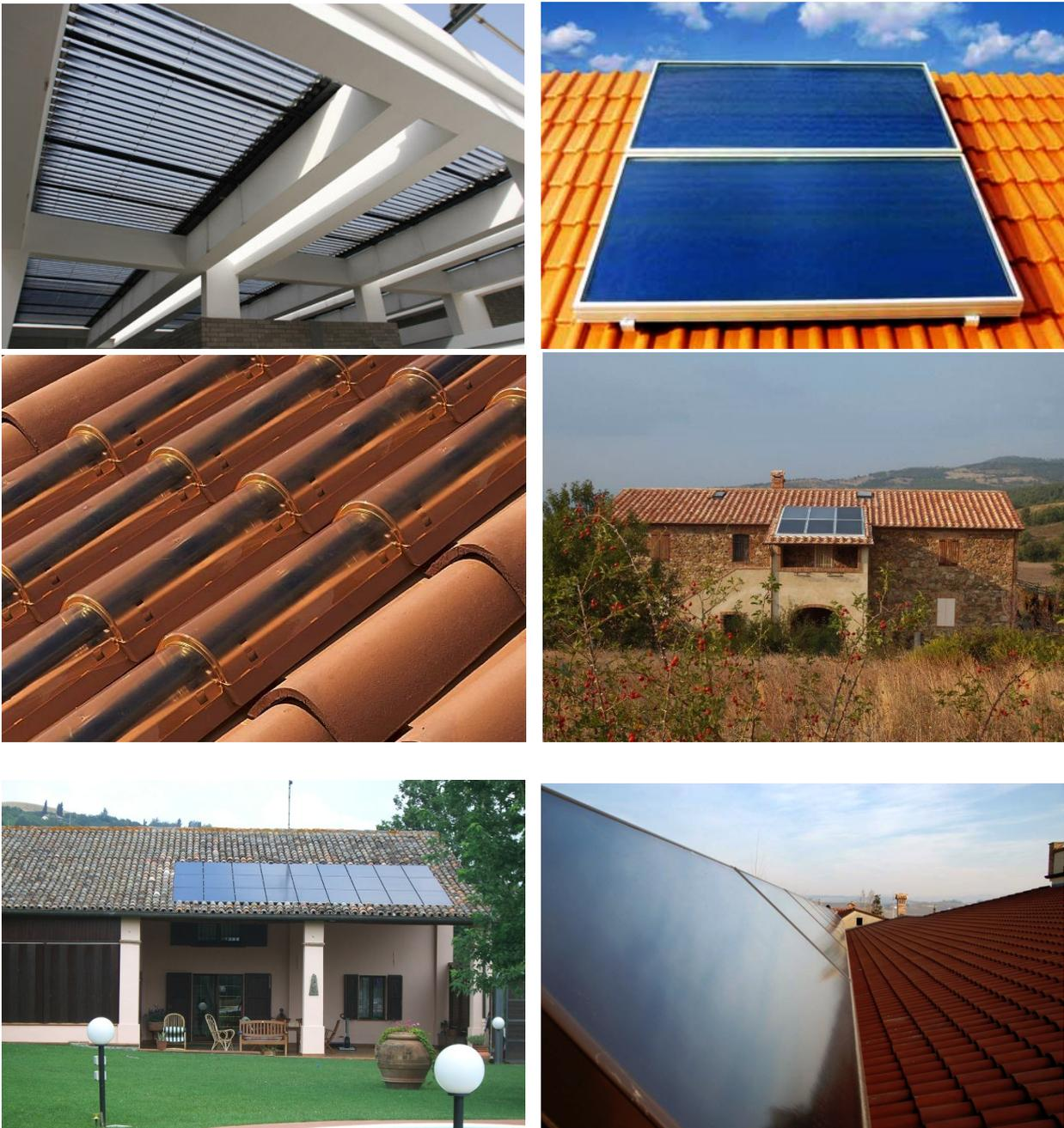
Figura 12 – Esempio di installazione di pannelli solari termici.
